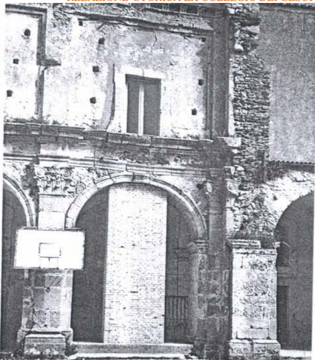
A. Depressione dell'arco e suo consolidamento mediante puntellamento con struttura in laterizio.
