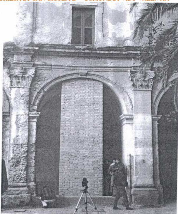
B. Depressione dell'arco e suo consolidamento mediante puntellamento con struttura in laterizio.
