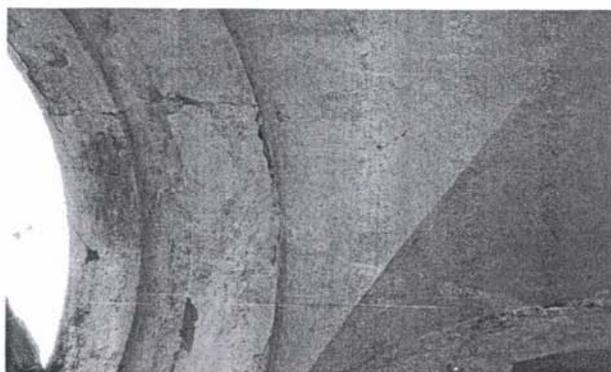
L. Lesione della volta di copertura del porticato, la lesione misura circa cm. 0,5.
